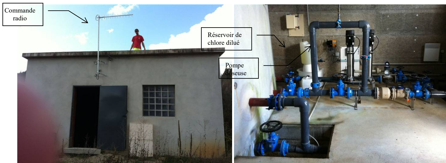
Réservoir de Marance
